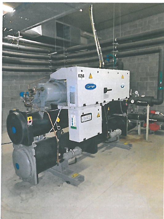
Tepelné čerpadlo.
