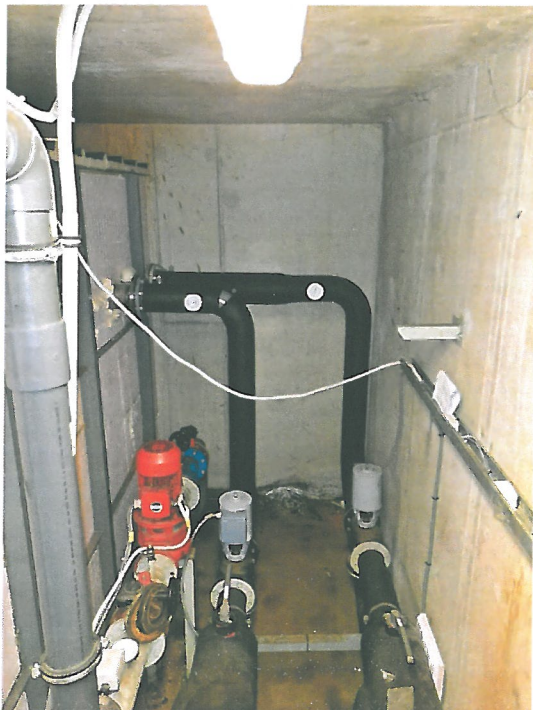
Změna technologie a potrubí pro tepelná čerpadla.
