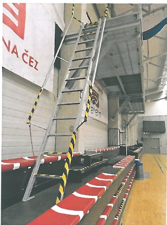
Montáž schodů pro potřeby kameramanů na míčové hale.
